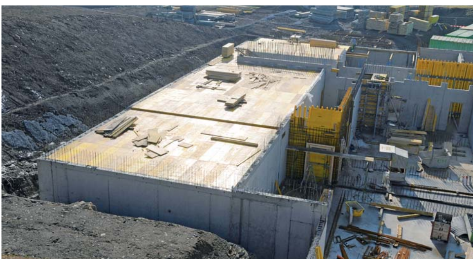
3. Februar 2009 Die Turnhalle ist bereits gedeckt.
