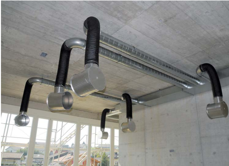
10. September 2009 Die Fenster sind bereits montiert – die Dunstabzüge noch nicht ganz ...
