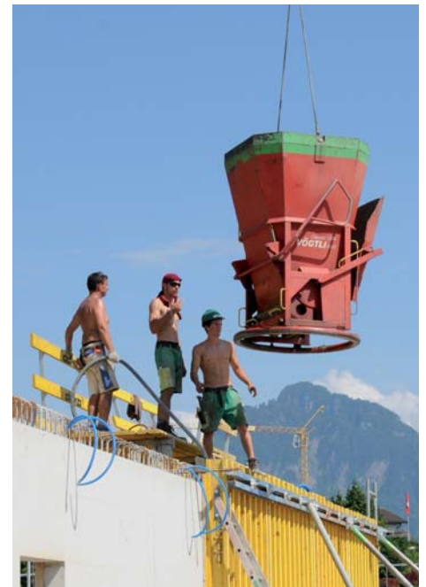
18. Juni 2009 Noch ist nicht fertig mit Betonieren.
