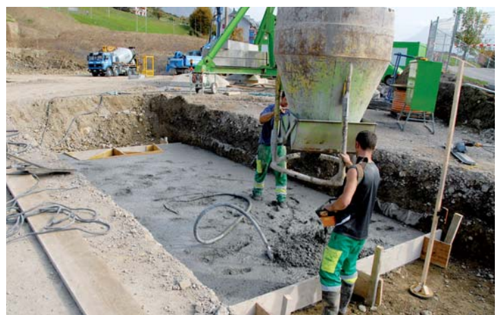
14. Oktober 2008 Hier wird auf solidem Grund betoniert.
