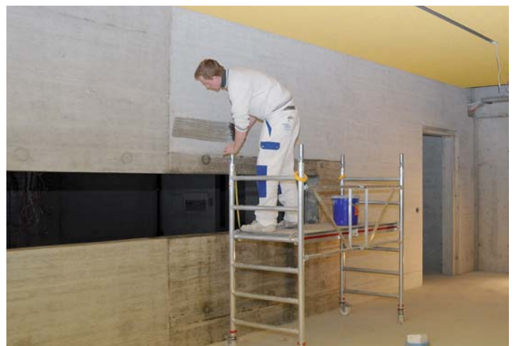
11. Januar 2010 Wellness für Betonwände
