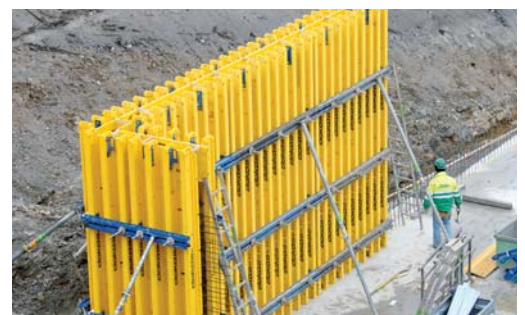
26. November 2008 Und hier steht die erste Wand.
