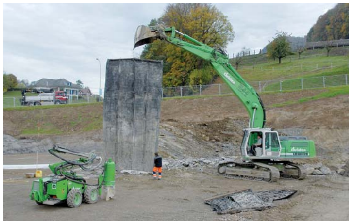
27. Oktober 2008 Sprengarbeiten müssen gut vorbereitet werden.
