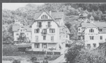
Die Bautätigkeit im Dorfzentrum – hier die «Neue Rigistrasse» aus dem Jahr 1906 – setzt dem Schiessstand neben dem Alt-Schulhaus ein Ende.
