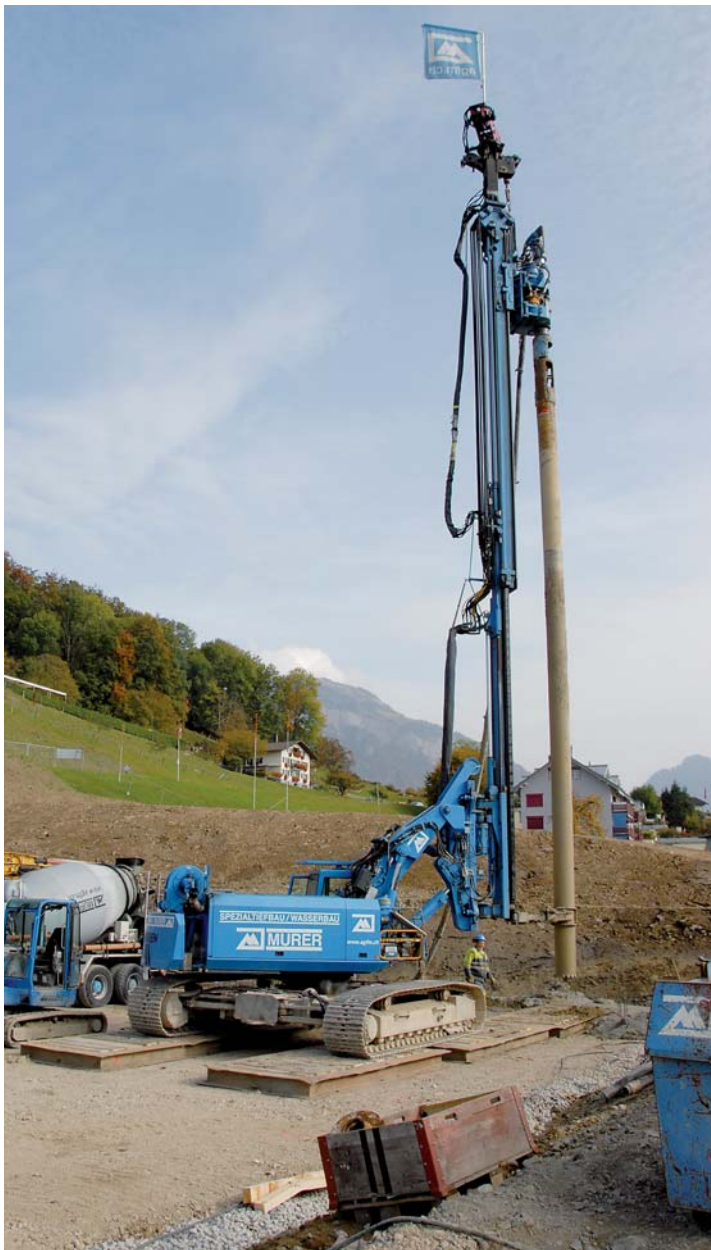
14. Oktober 2008 Auch Pfählungen sind notwendig.
