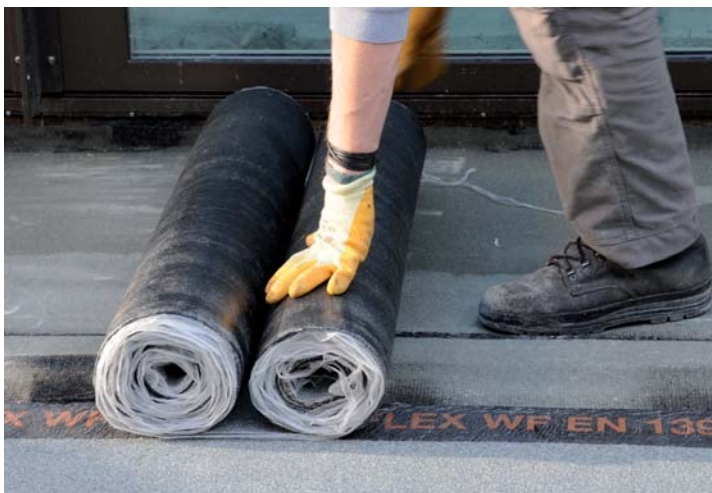
23. November 2009 Jetzt wird abgedichtet.
