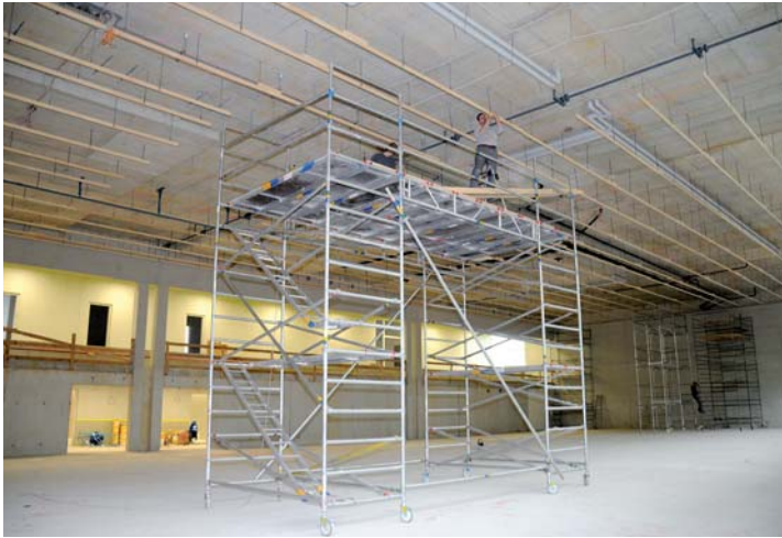
19. Februar 2010 Die Stützen in der Halle sind weg – jetzt kommt die Deckenverkleidung.
