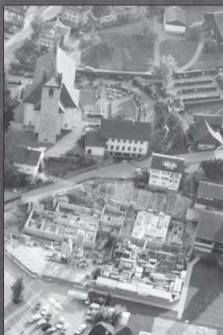
«Die Schule soll im Zentrum bleiben!» Hier die Baustelle zwischen Dorf- und Kirchmattschulhaus am 18. Juni 1980.
